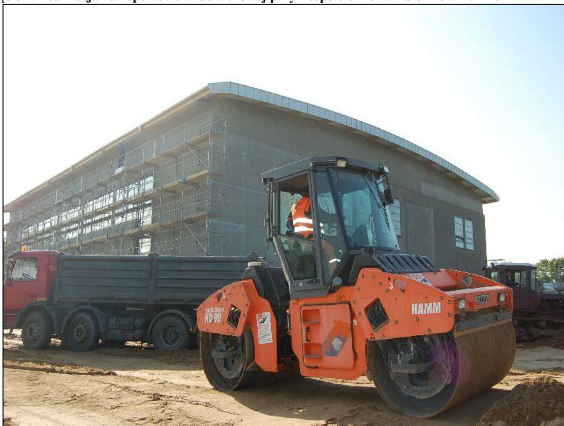
Zdjęcie 1. Realizacja hali sportowo-widowiskowej przy Zespole Szkół w Zbicznie w 2014r.
