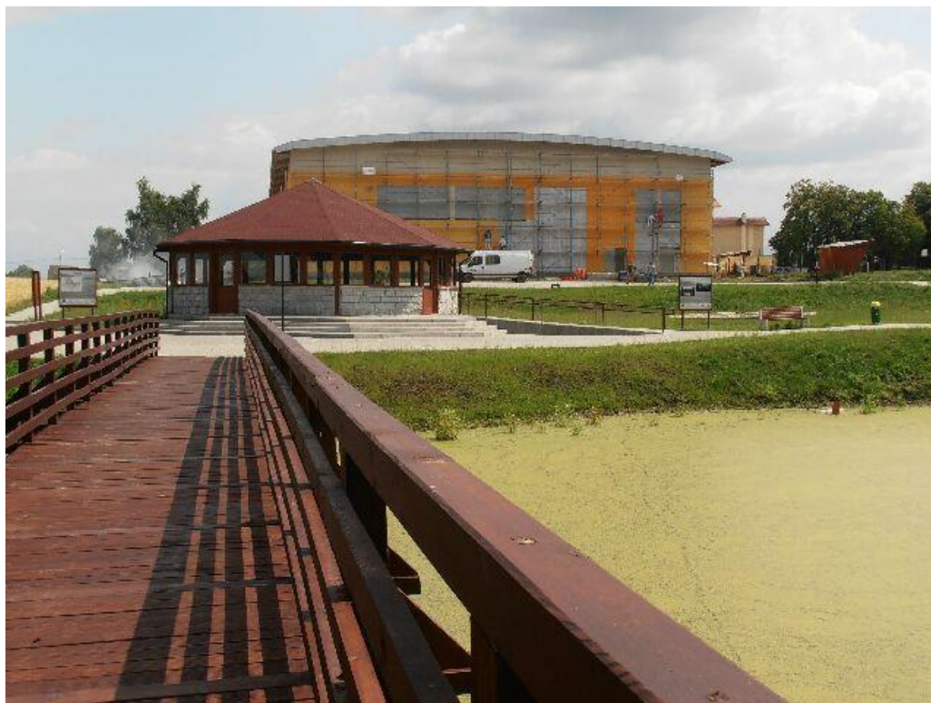
Rysunek 16 Budowa Hali Sportowej w Zbicznie (źródło: http://goksirzbiczno.ubf.pl )
